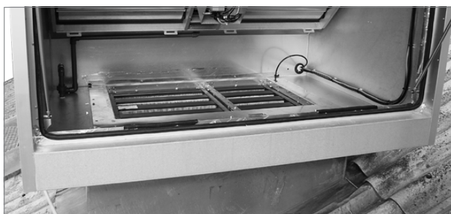
Imaginea 28: Filtrul pentru aer de evacuare instalat în aparat
